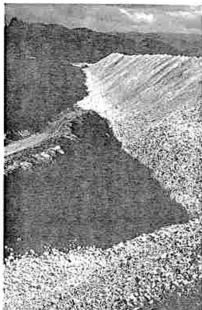
Abb. 2: Kontaktbereich der Kippe Schaffos mit dem im W anschließenden waldbestan- ken. Frische Schüttung, die groben Blöcke im unmittelbaren Kontakt zum nicht zerfallen. Aufnahmezeitpunkt: Juni 1989
