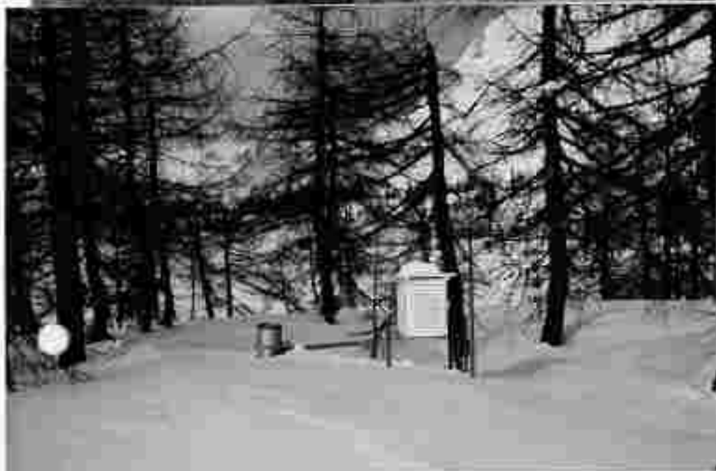
Auf Abb. 23 sieht man die St. Linnerhaus bei etwa 3m Schneehöhe im ursprünglichen Zustand (22.1.1985). Außer der hier zu sehenden Südseite wurden alle anderen Seiten mit Lackplatten bestückt. (siehe auch Kap. 9)
