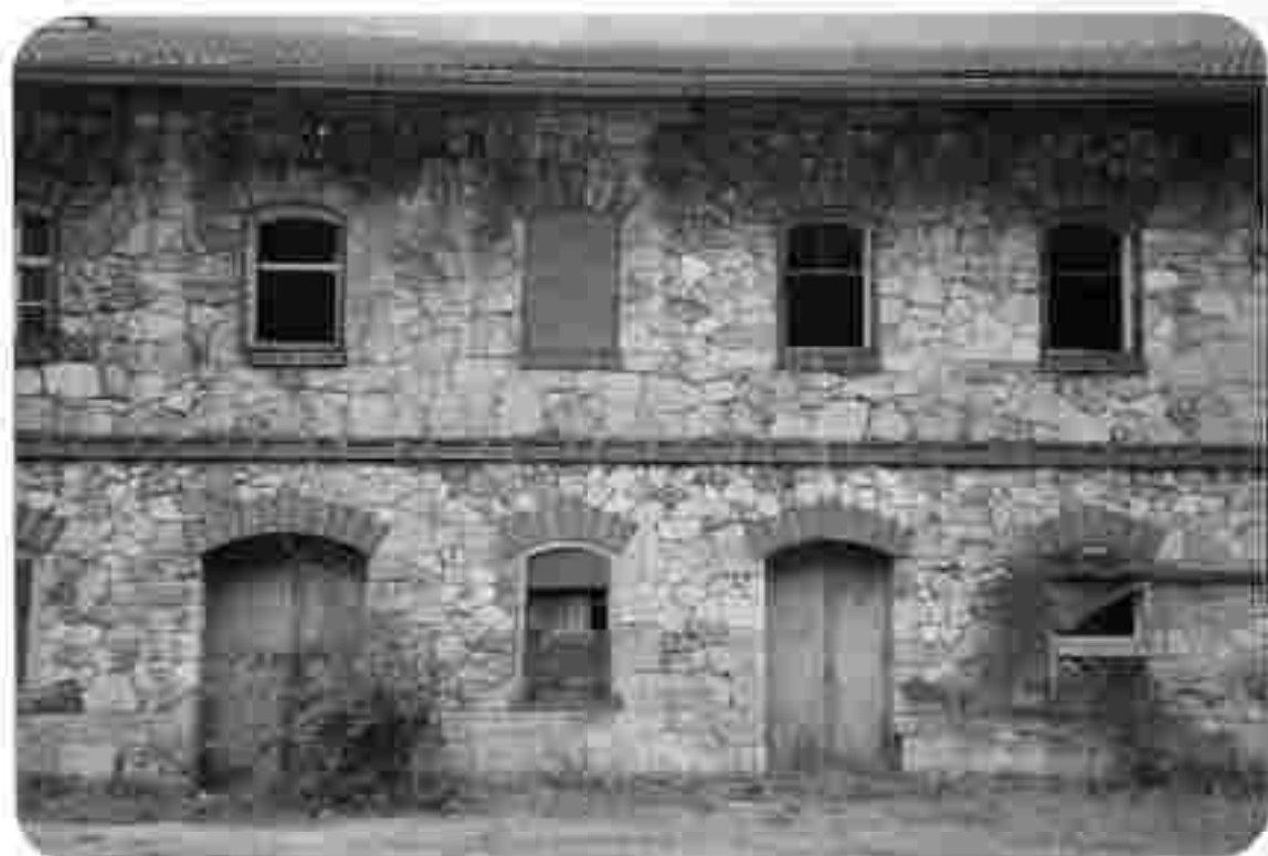
Abb.3: Altes Kraftwerk-Betriebsgebäude NNW Bahnhof Vorderberg, bei dem neben Kalksteinen auch quartäre Konglomerate/Brekzien als Baustein Verwendung fanden.
