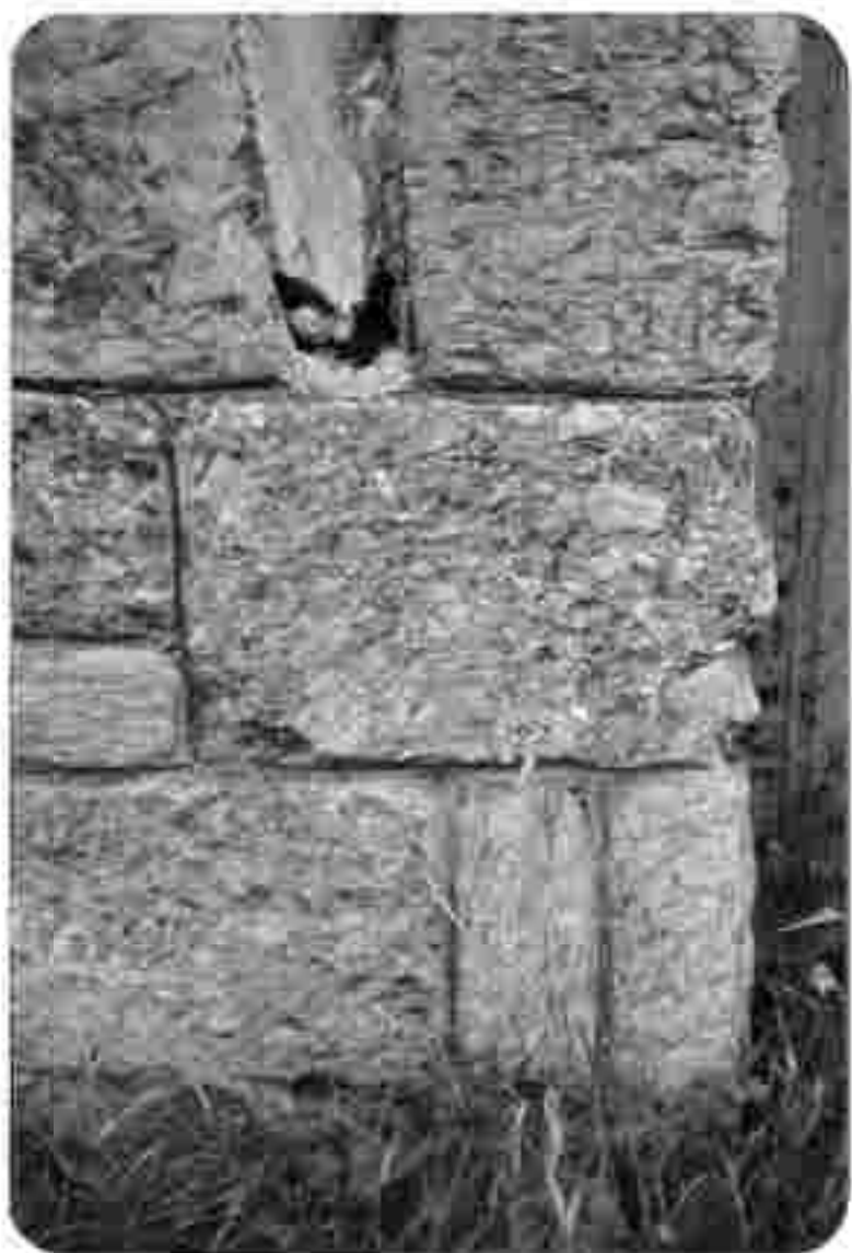
Abb. 6: Kraftwerks-Betriebs- gelände, NW Bahnhof Vorderberg: Eingebau- te Konglomerat/ Brekzien-Bausteine zeigen a) gute For- matisierbarkeit und b) große Verwitter- ungsresistenz.
