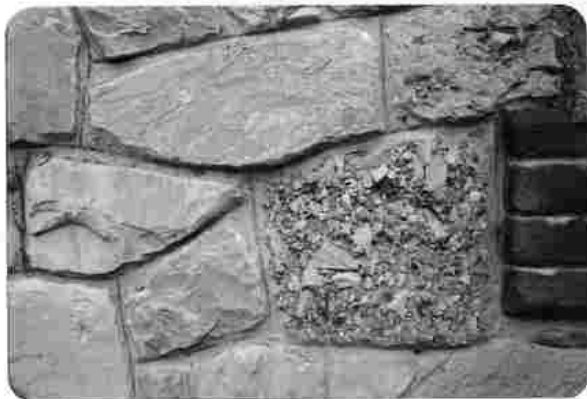
Abb.4: Detail aus dem Mauerwerk des Kraftwerk-Betriebsgebäudes NNW Bahnhof Vorderberg mit eingebautem Konglomerat/Brekzien-Block.
