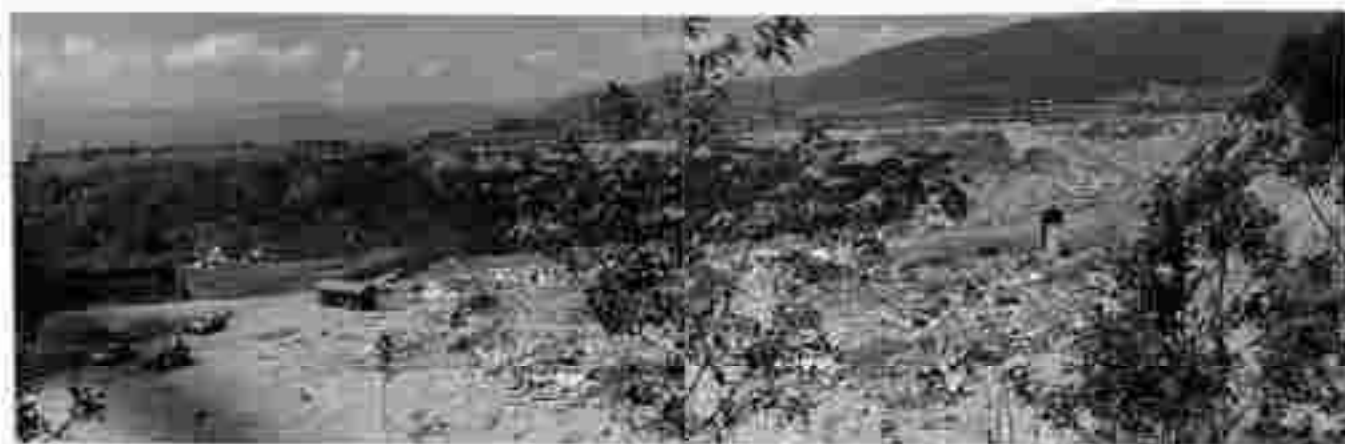
Abb. 24: Spielberg, Pausendorf; Schottergrube außer Betrieb; geordnete Mülldeponie mit Asphaltdeckung
