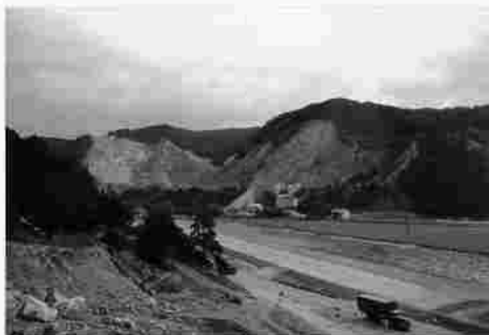
Abb. 15: Hartsteinwerke Preg 0910/1. Dickbankige Serpentinite im Etagenbau gewonnen.
