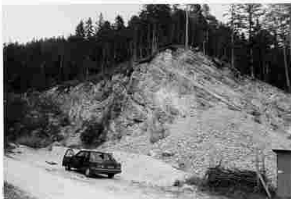
Abb. 8: Quarzbruch Rettenegg - Ziegerhofer 1743/3. Das hier gewonnene und in ausreichenden Vorräten vorliegende Material eignet sich bestens zum Straßen- und Wegobau.
