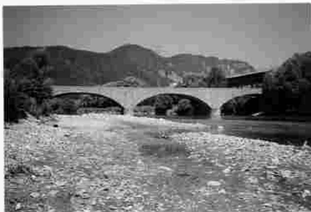
Abb. 20: Granitgneise des Humpelgrabens eingesetzt als Baumstein bei der Murbrücke Peggau - Deutsch Feistritz.
