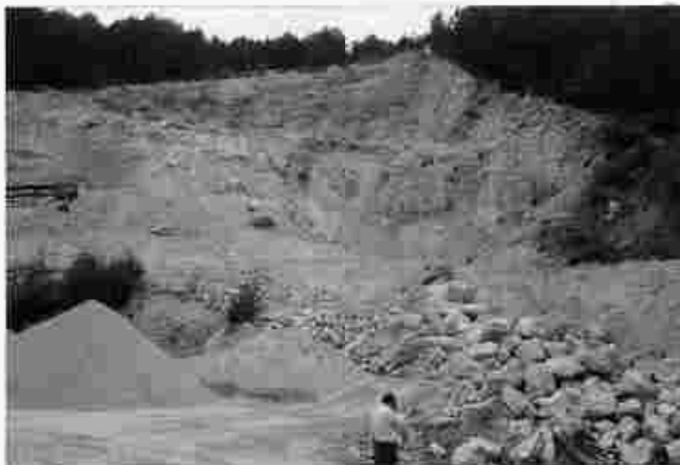
Abb. 18: Steinbruch Trippl, Kapfenberg-Winkel, 0209/1. Aufgeschlossen sind dickbankige bis massige dolomitische Kalke.
