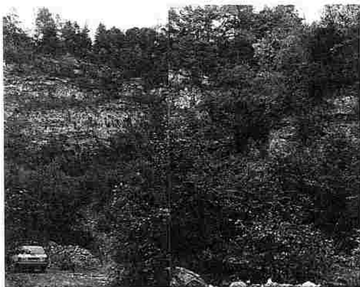
Abb. 24 : Regenerierter Kalksteinbruch Bruck, südöstlich des Bahnhofes, differenzierte Hangflächengestaltung (wenig auffallend).
